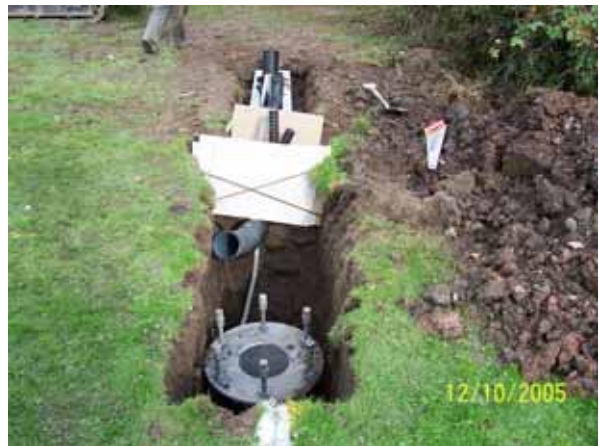
Column root sections prior to concrete pour
